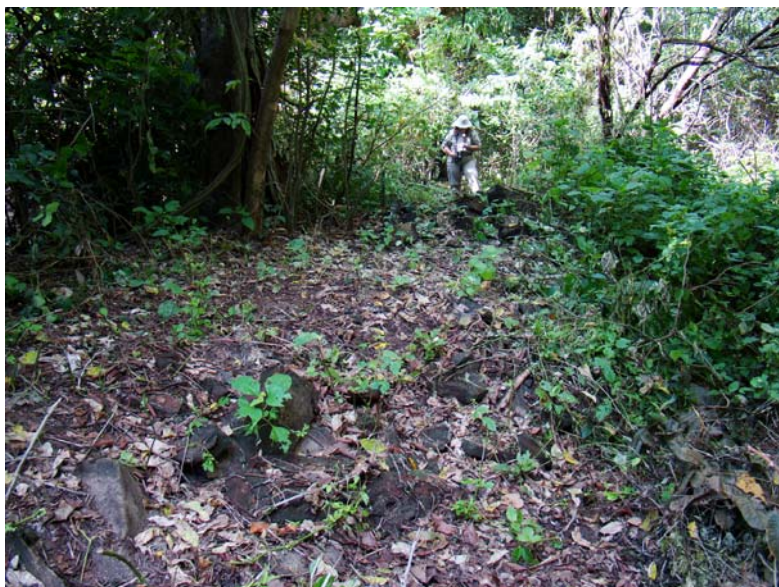
Vestígio de construção em alvenaria de pedra e tijolo co presença de cimento Portland.
